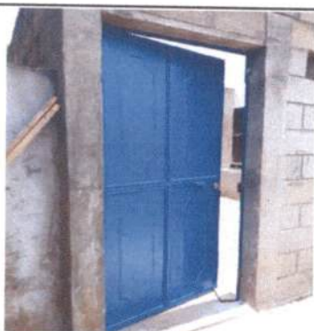
Foto 3: Instalación de puerta y cambio de estructura de madera por metal en cocina.
