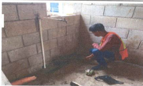
Foto 5: Realizando trabajos para sustituir la pila en cocina.
