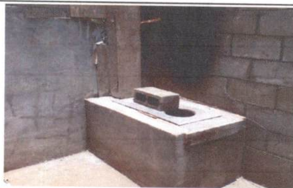
Foto 4: Colocando el tubo para chimenea y ladrillos en la estufa de la cocina.
