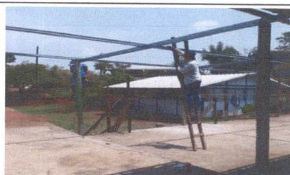
Foto 6: Iniciando la colocación de lámina troquelada en el corredor de la escuela.
