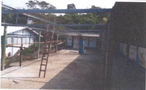
Foto 1: Sustituyendo estructura de madera por metal en corredor y cocina.
