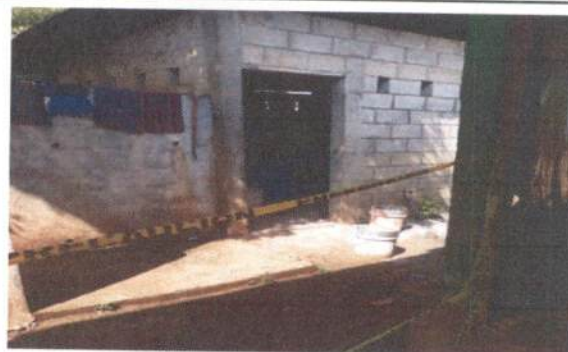
Foto 2: Área cercada para iniciar los trabajos en el área de la cocina.
